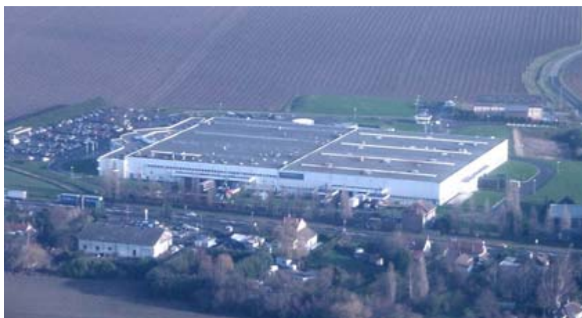
Les nouveaux établissements d'Aertec, à Villeron
